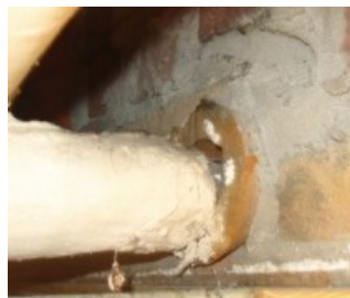
Boven: 2 voorbeelden van niet-brandwerend afgewerkte doorvoeren. Rechts: afgezaagde deur in subbrandcompartimentscheiding.
