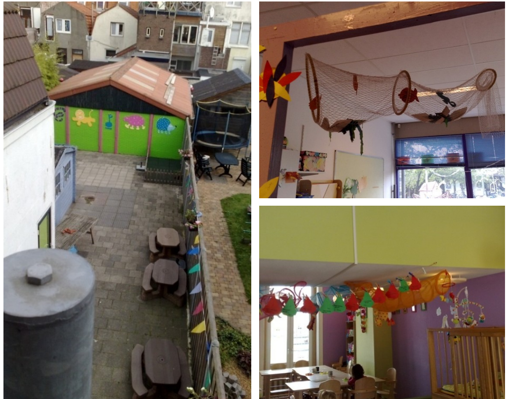
Links: doodlopende vluchtweg. Rechts: niet-geïmpregneerde versiering aan plafonds.
