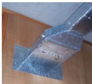
Boven: 2 voorbeelden van niet-brandwerend afgewerkte doorvoeren. Rechts: afgezaagde deur in subbrandcompartimentscheiding.
